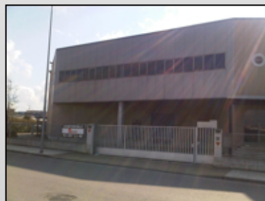
PARETS DEL VALLÉS Alquiler nave 3.068 m 2
